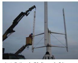
Installation de l'éolienne le 24 mars
