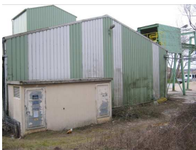
Réinjection dans le réseau électrique depuis le poste de la FAC
