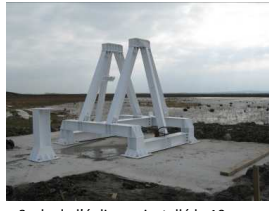
Socle de l'éolienne installé le 10 mars
